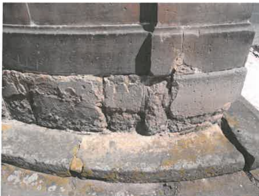
2. Pata podstavce, schody
